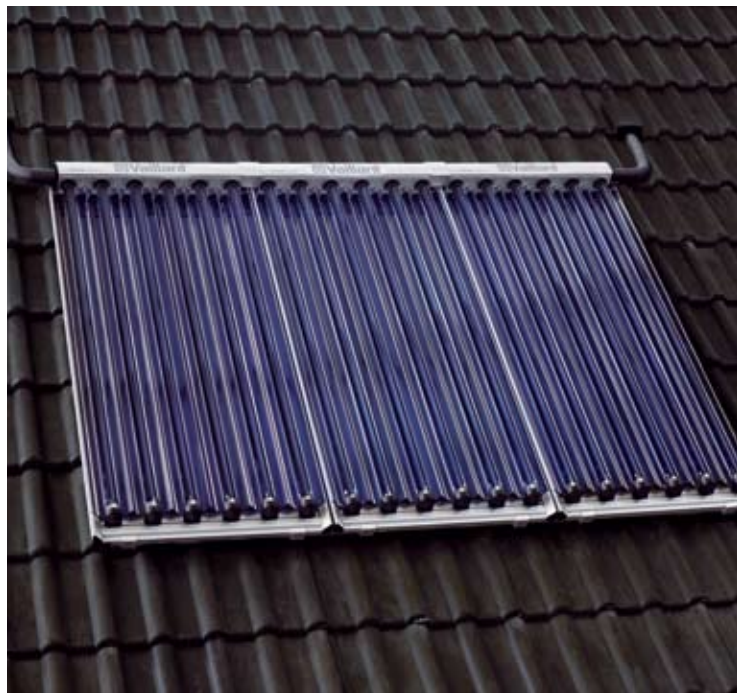
3 stk. auroTHERM eksklusiv VTK 570 solfangere installeret på skråt tag.
